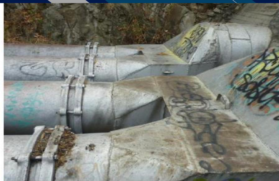
Derivación de dos conductos a cuatro de 24 in de diámetro, se conduce  $2.0$  m<sup>3</sup>/s
