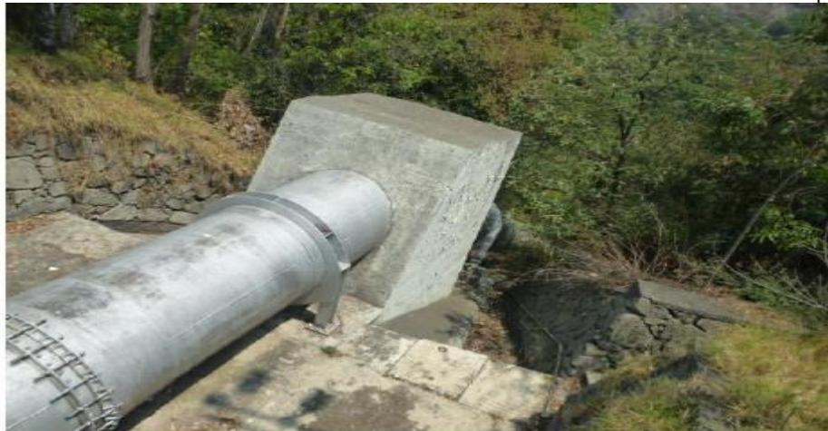
Línea a Presión, salida del tanque de Carga de la caída El Borracho. Esta línea no está en operación, ya que esta inconclusa, en la descarga se cuenta con la preparación del arreglo mecánico para la instalación de turbinas de generación.
