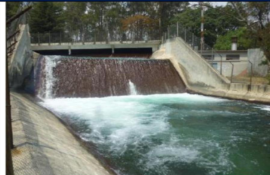
Vertedor de salida del Tanque de Carga, parte de la Estructura de By Pass
