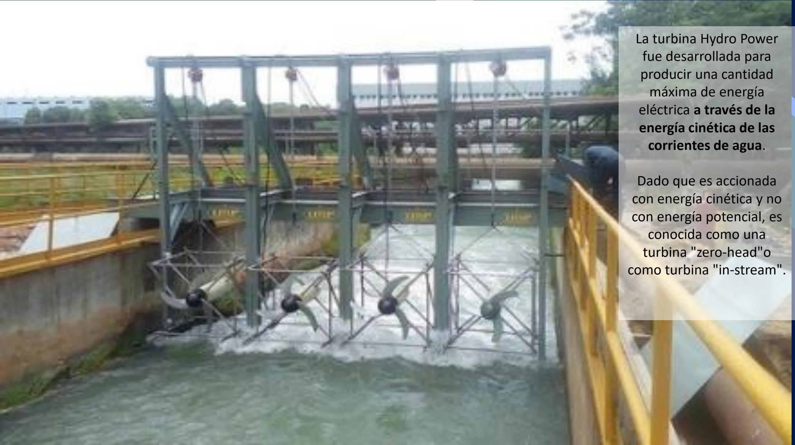
La turbina Hydro Power fue desarrollada para producir una cantidad máxima de energía eléctrica a través de la energía cinética de las corrientes de agua.
