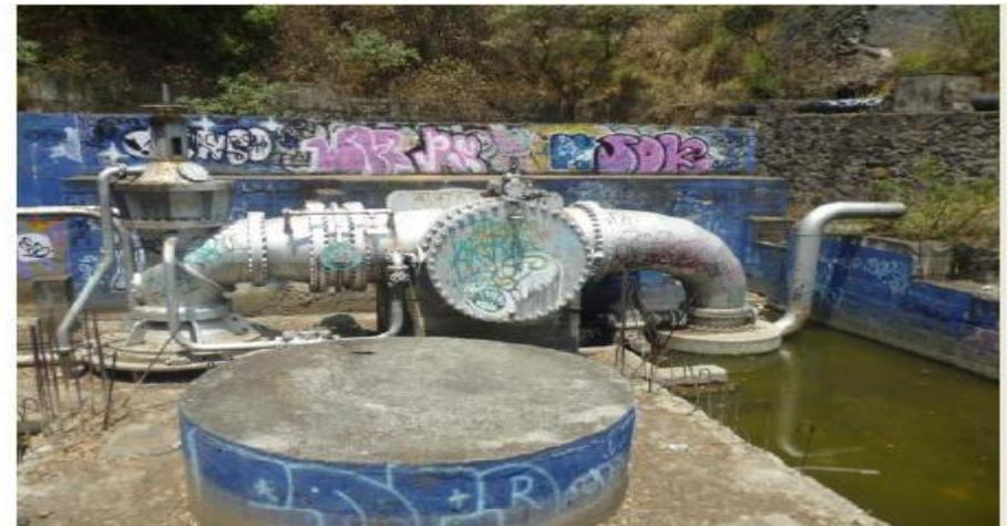
Esquema de preparación de turbinas de generación de energía. Para el aprovechamiento de una caída bruta de 46.13 m, y un gasto promedio de  $2.0 \text{ m}^3/\text{s}$
