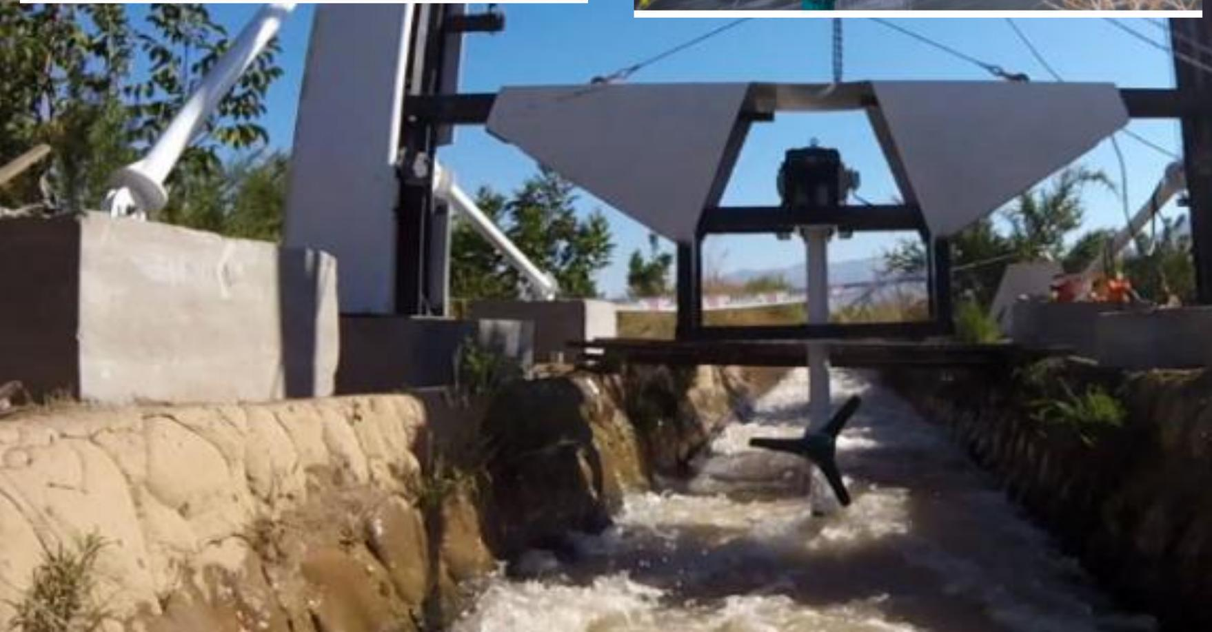
*Según las condiciones del canal, una sola turbina puede generar 10 kW de potencia, es decir, de funcionar las 24 horas, genera suficiente energía como para suministrar lo que consumen en promedio 38 casas durante un mes de verano.*
