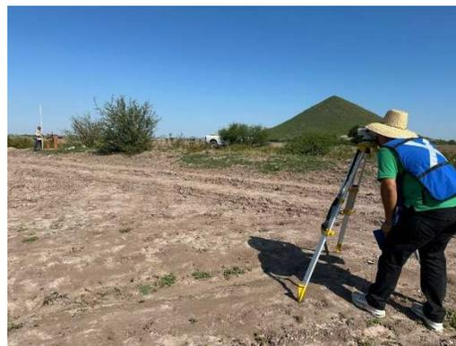
**Figura 6.** Toma de lectura en levantamiento con nivel fijo
