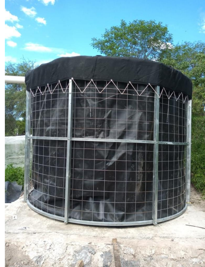
Geotanque de 23,000 con estructura reforzada de PTR y geomembrana PEAD
