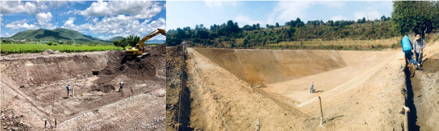
Excavación y afine de taludes
