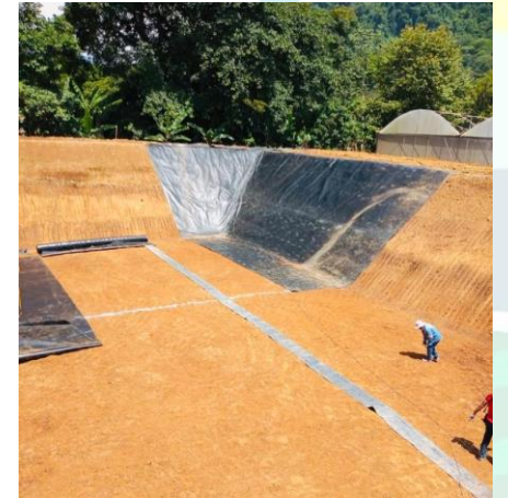
Suministro e instal. Geomembrana.
