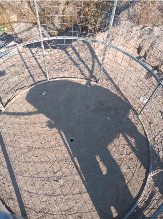
Cimentación, estructura y obra de toma
