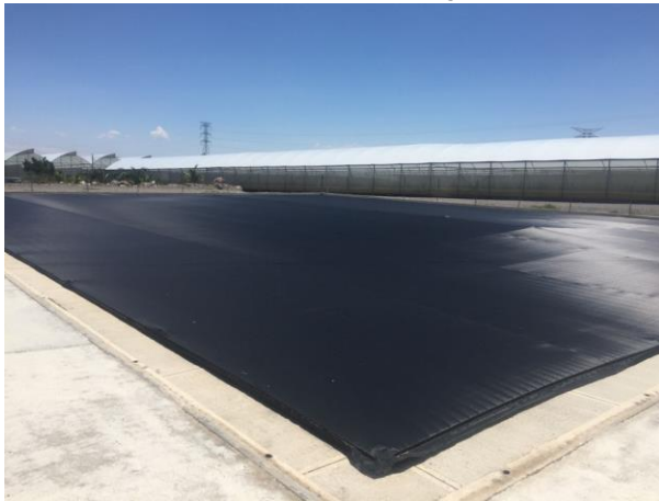
Cercado perimetral y banqueta
