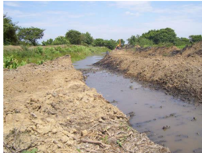
Figura 7. Extracción de sedimentos y maleza acuática
