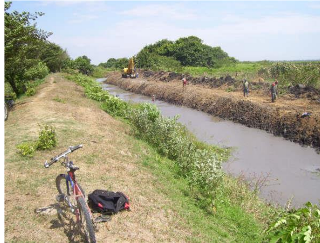
Figura 6. Adecuación del dren interceptor
