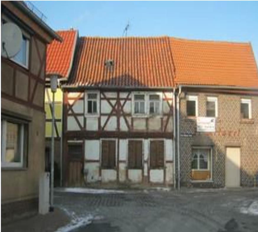
Abandono, fase (1) casas abandonados, Todavía intactos en Heringen (Helme)
