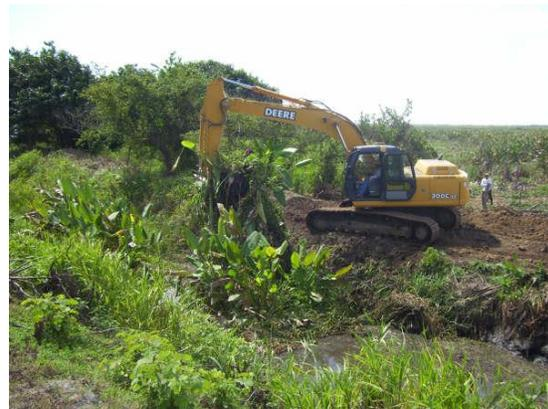
Figura 6. Extracción de sedimentos y maleza acuática
