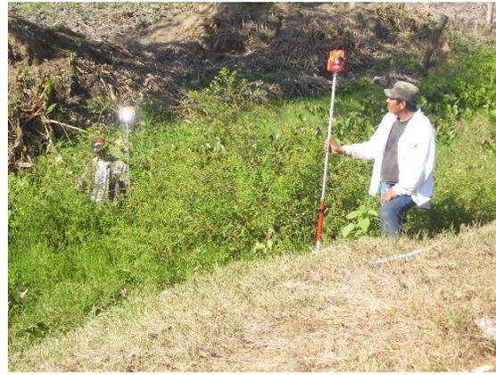
Figura 2. Levantamiento topográfico: perfil y secciones trasversales
