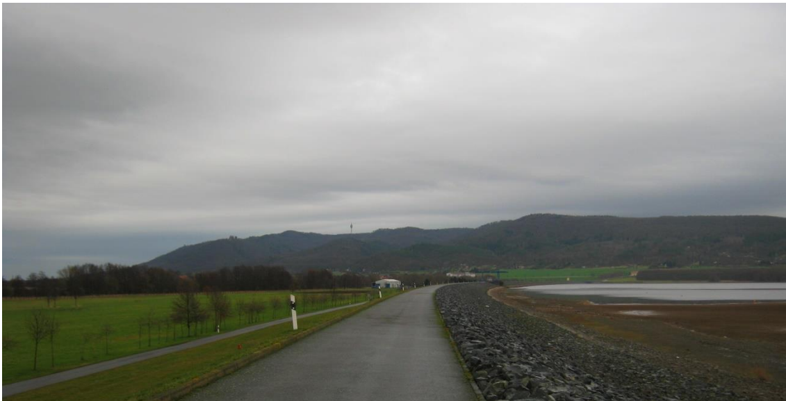
Figura 1. Dique de la represa Kelbra sobre el río Helme a niveles reducidos invernales, para poder captar las aguas del derritamiento de nieve primaveral del sistema montañosa del Harz, evitando inundaciones en la densamente poblada cuenca baja.
