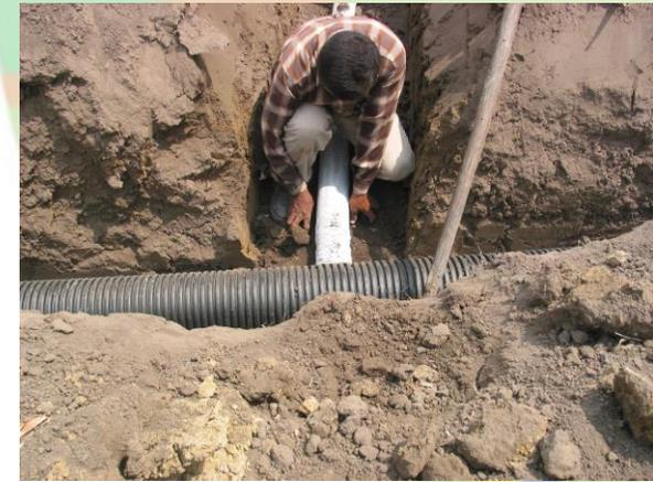
**FIGURA 11.** Instalación del sistema de drenaje
