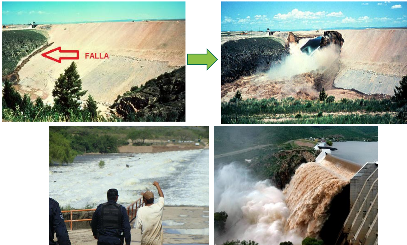
Fig.2. Falla en presa Teton, Idaho, E.U. (Arriba) . Aumento de volumen de almacenamiento y descarga (Abajo)
