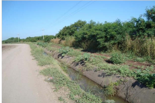
Tramo en estado regular las losas comienza a fracturarse
