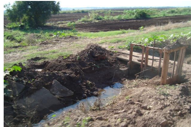
Tramo en mal estado donde se ha perdido el revestimiento
