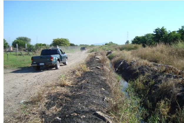
Tramo en mal estado donde se ha perdido el revestimiento
